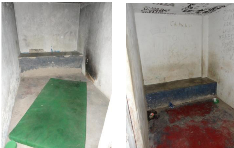
Fotos: superior, vista exterior de la celda segunda; inferior, interior de la primera y segunda celda, respectivamente.
