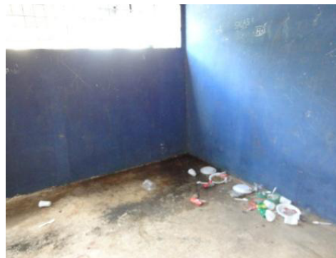
Foto: área de celdas de la Delegación Cantonal de Fuerza Pública de Nicoya
