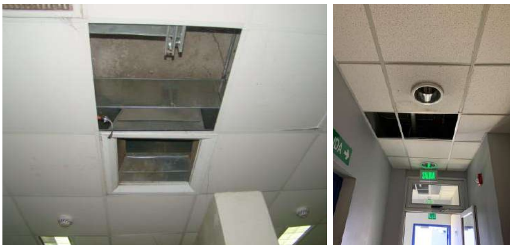
Fotografías: Láminas del cielo raso desprendidas en las delegaciones policiales de la Fuerza Pública de Pérez Zeledón (izquierda) y Guararí (derecha).
